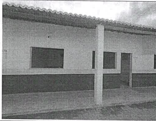
Visão do interior da escola
